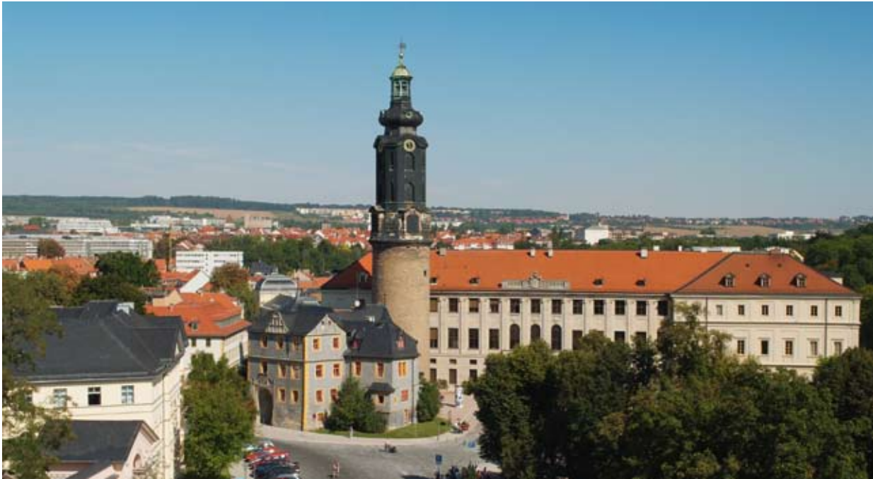
Stadtschloss Weimar, Ansicht von Süden
