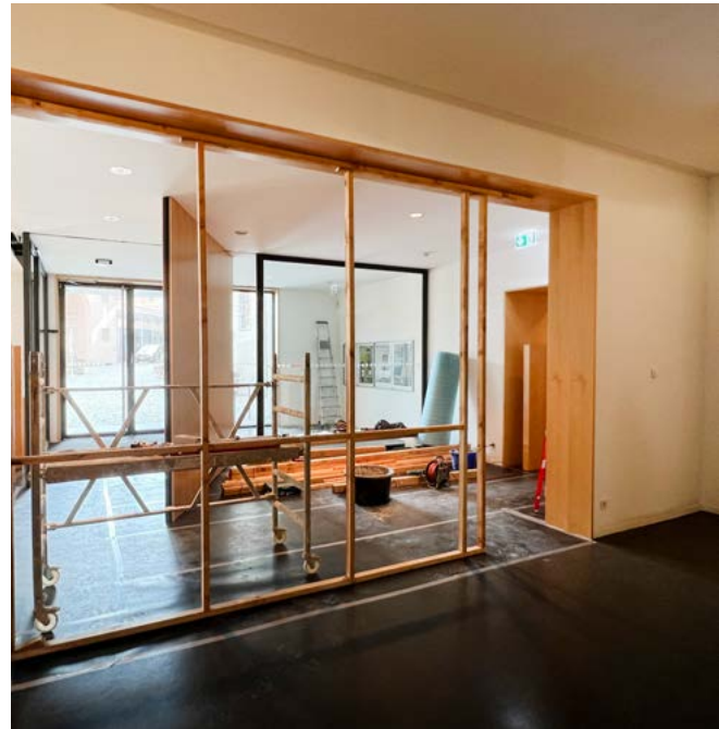
Bauarbeiten im Foyerbereich des Studienzentrums
