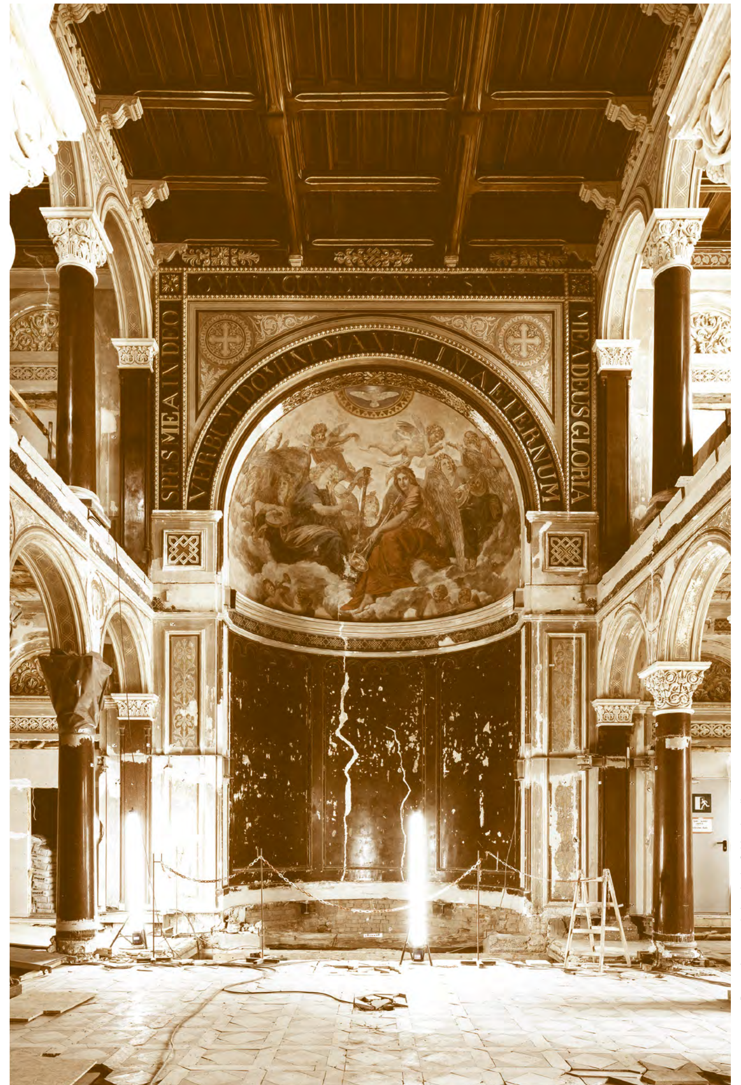
Restaurierungsarbeiten in der Schlosskapelle
