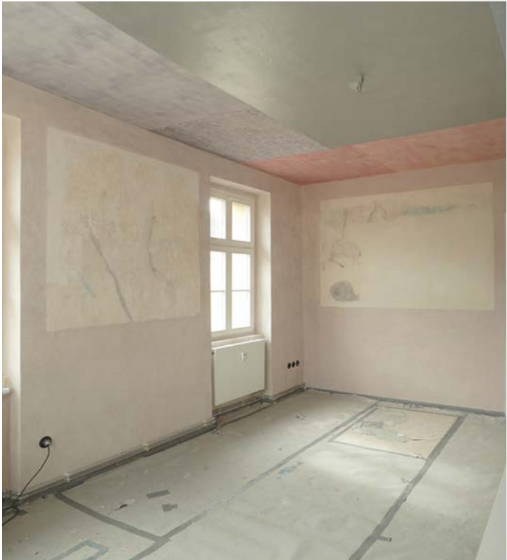
Ost- und Südwand, Zustand Juni 2023
