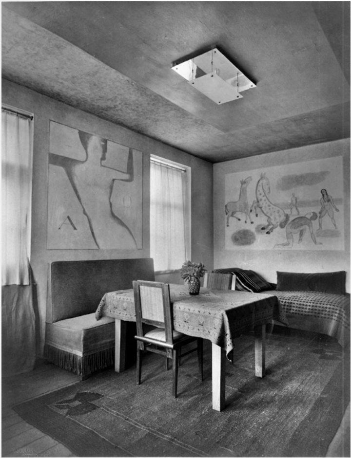
Ost- und Südwand, Aufnahme um 1923
