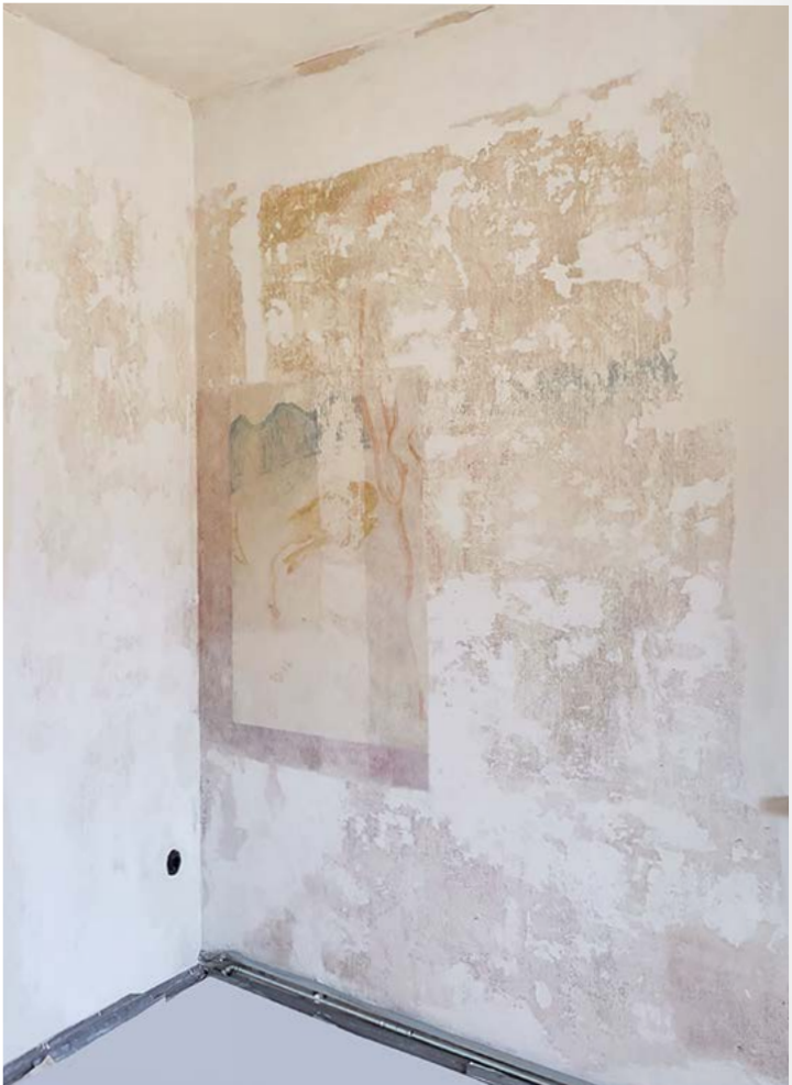
Nordwand, Zustand April 2023
