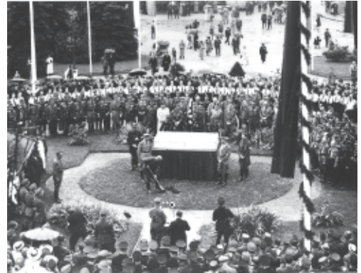
Gauleiter Sauckel und Hitler beim ersten Spatenstich zum späteren Gauforum, 4. Juli 1936 (Foto Stadtmuseum Weimar)
